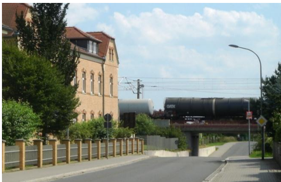
Bahnbrücke über Steinweg in Borsdorf
