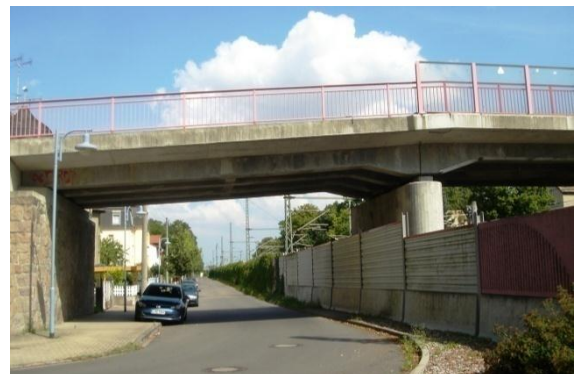
Schallschutzwände entlang ICE-Strecke in Borsdorf
