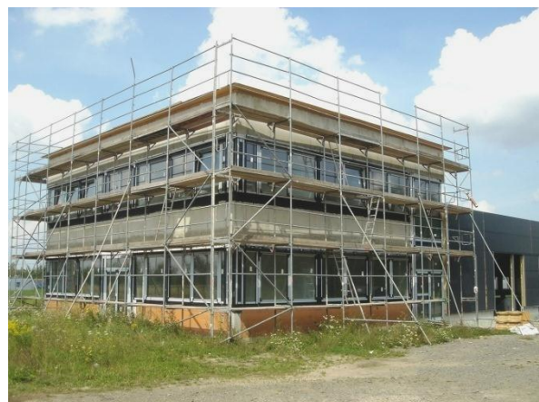
Neubau Gewerbegebiet „Borsdorfer Straße“ (08/2014)
