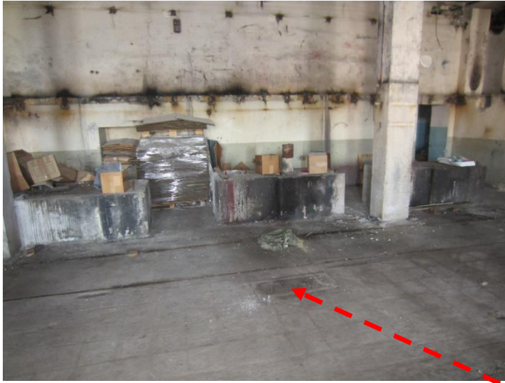
Bild 1: Fundamente Reibemaschine im EG, Paste durch Bodenöffnungen zu den Tanks im KG, April 2019
